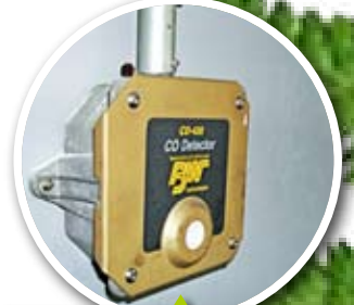
停車場採用CO濃度感知器偵測
