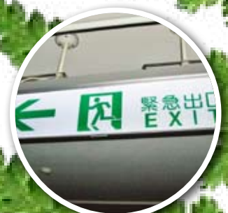
緊急出口指示燈採用LED燈具
