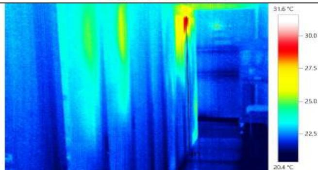
機櫃 A03-冷通道(設備散熱方向錯誤)
