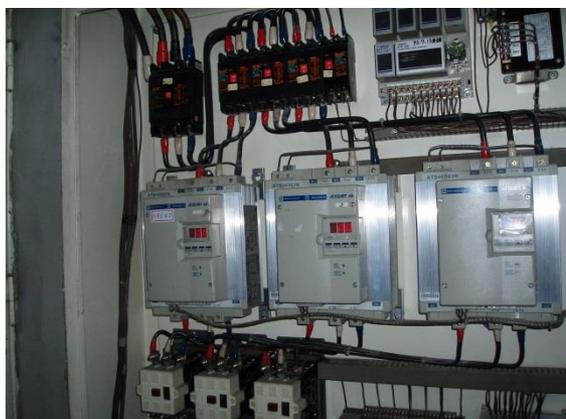
採用變頻器控制，高效率冰水及冷卻水泵運轉，減少用電。
