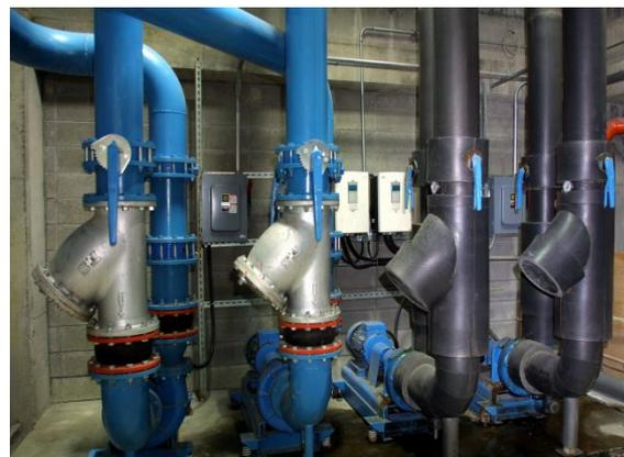
採用高效率冰水及冷卻水泵，減少用電。
