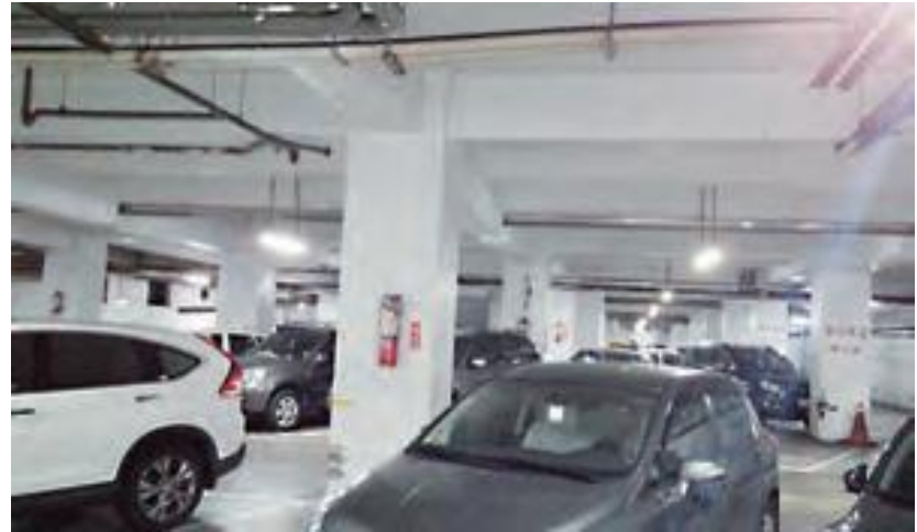
停車場採用LED管型燈源 送排風機每小時運轉15分鐘交錯開啟
