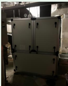
實際安裝照片
