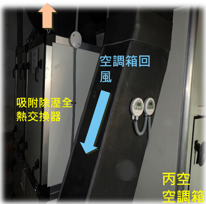
現場裝設照片
