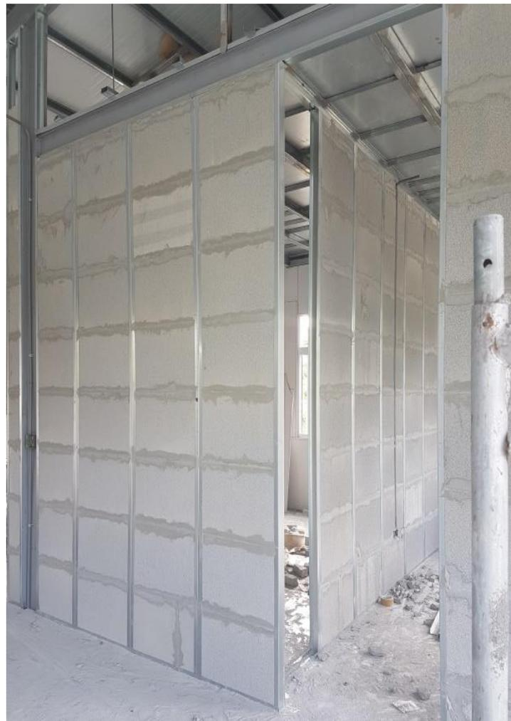
使用無機發泡隔熱材直接當建築物外牆案例
