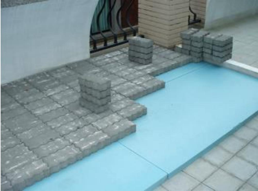
PS板上鋪設高壓混凝土磚
