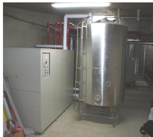
圖 3.2 冷凍冷藏主機之熱回收控制閥及供應熱水使用
