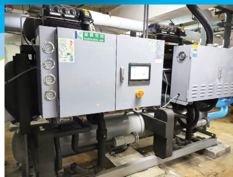
新增高效率磁浮離心式冰水主機
