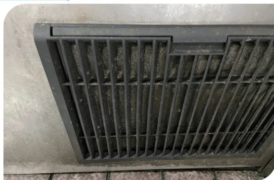
定期清潔冷凝器散熱片，降低冷凝溫度
