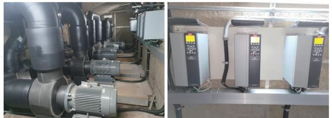
既設一/二次冰水泵汰換為高效率水泵 冰水及冷卻水系統加裝變頻控制
