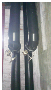
冰水管路保溫材改善
