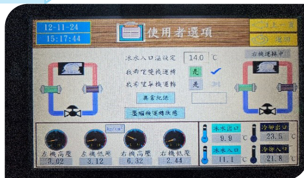
隨季節調整冰水出水溫度(夏：7℃、冬：9℃)
