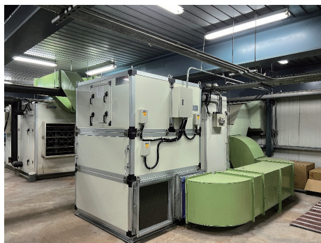
新設吸附式全熱交換器
