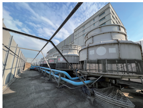
汰換冷卻水塔並更新為IE3馬達
