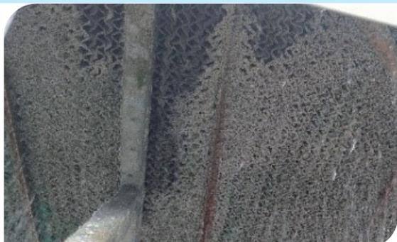
改善散熱片結垢、青苔，水盤盤底積存污泥
