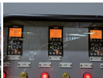
新設之1,125RT冷卻水塔 冷卻水塔風扇加裝變頻控制
