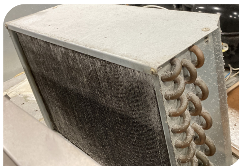
定期清潔冷氣機冷凝器散熱片，降低冷凝溫度
