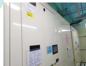
增設箱型冷氣機
