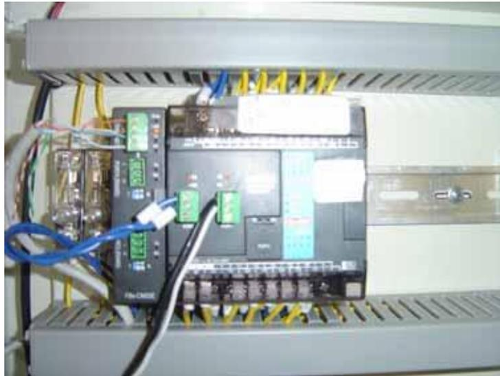
圖3.3-2可程式控制器（微小型）外觀圖
