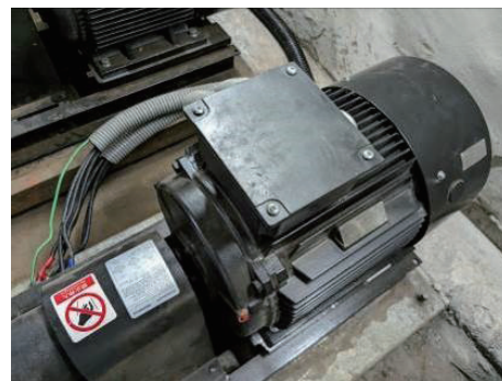
既設區域泵汰換為高效率水泵
