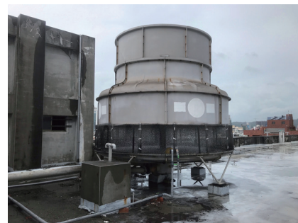
冷卻水塔散熱材更換
