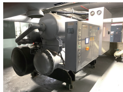
汰換變頻主機
