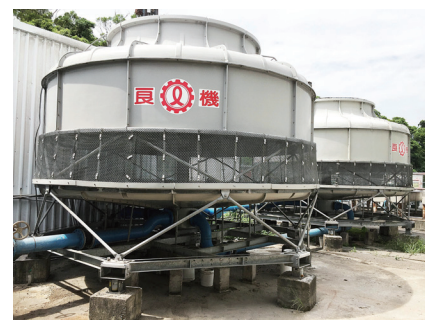
空調附屬設備汰換
