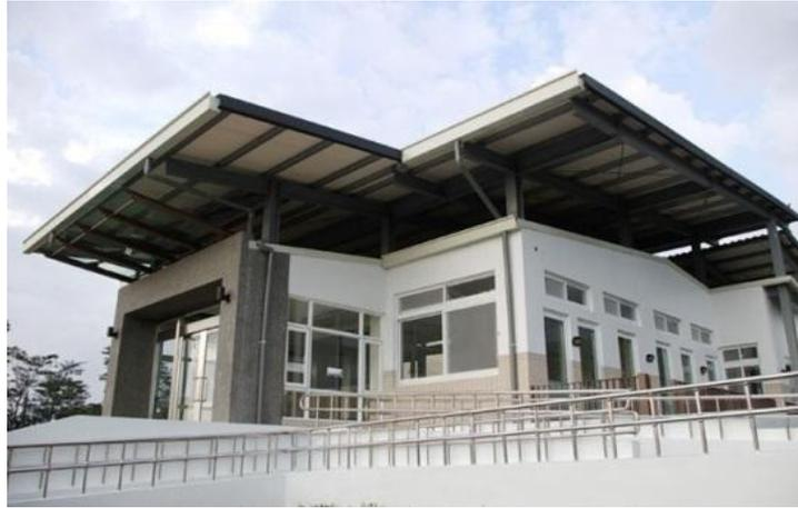
圖 3.6-6 架設鋼板屋頂
