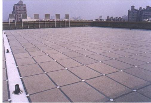
圖 3.6-2 防水層外鋪設隔熱磚
