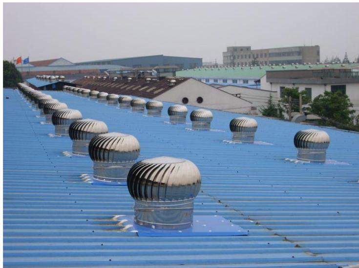
圖 3.6-7 鐵皮屋頂裝設通風扇來加強雙層屋頂的通風散熱
