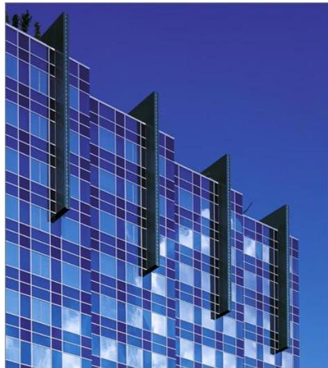
圖 3.8-3 大樓外觀使用反射玻璃
