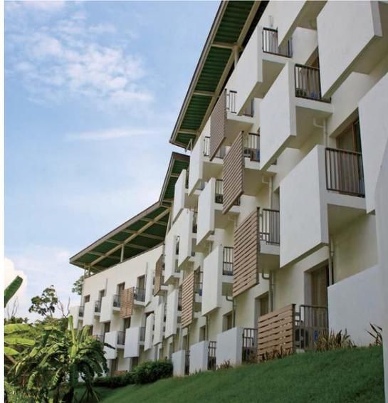
圖 8-3 外牆立面採用白色隔熱漆塗裝[23]
