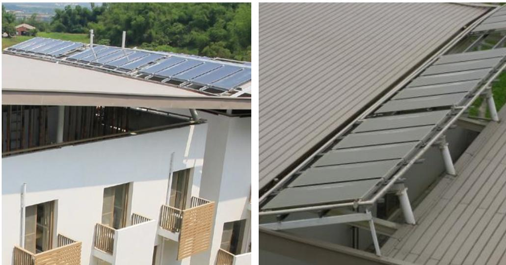
圖 8-6 屋頂設置太陽能熱水器[24]
