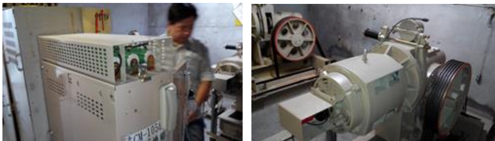
圖 6.2-5 電梯電力回生裝置偕同維保廠商測試
