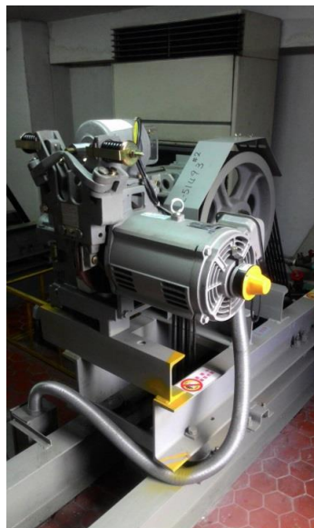
圖 6.4-1 電梯電力回生裝置節能案例現況實照
