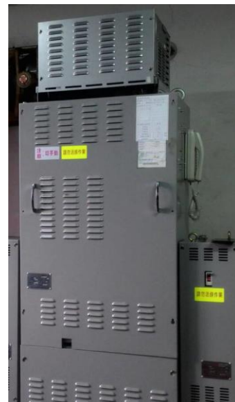
圖 6.4-1 電梯電力回生裝置節能案例現況實照
