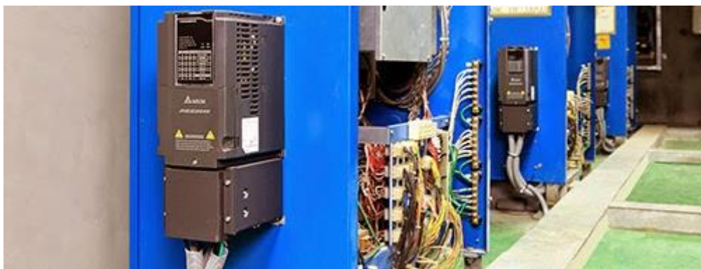
圖 4.4-1 電梯系統整體增設電力回生裝置【33】
