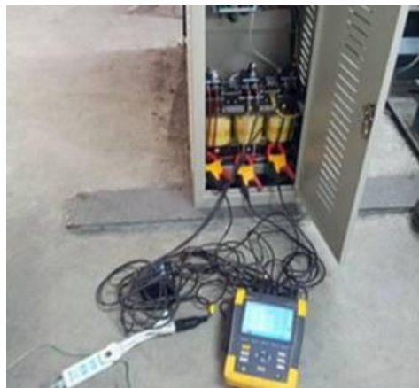
圖 6.4-9 電梯電力回生裝置節能案例現況實照
