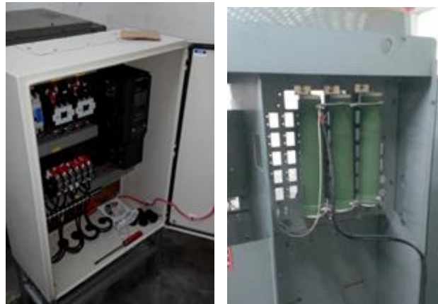
圖 6.2-4 電梯電力回生裝置使用實況及制動電阻裝設現況
