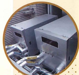
圖8 客房熱水採用熱泵
