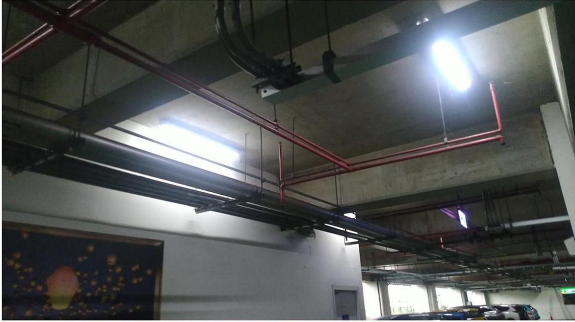
圖5-12 燈具(左方)被排水管路阻隔形成無效照明
