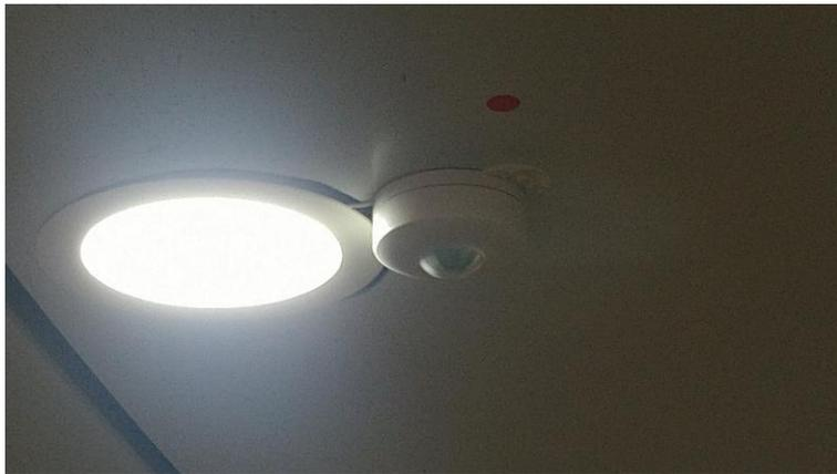
圖6-5 外掛式紅外線感測器(右側，現已有整合型產品)
