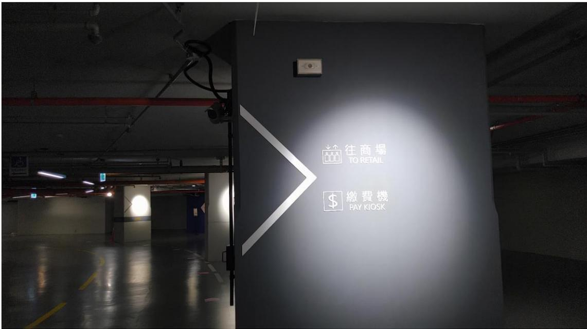
圖6-15 某飯店停車場梁柱重點照明示意圖
