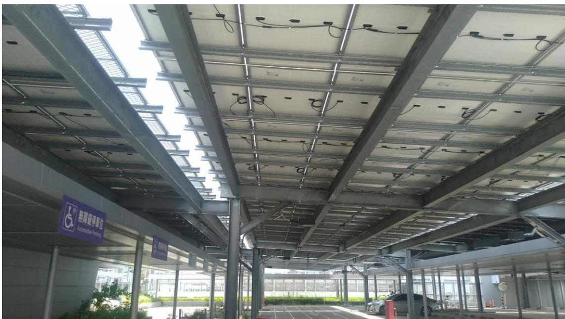
圖6-17 屋頂太陽光電的間隙與地面標線混淆
