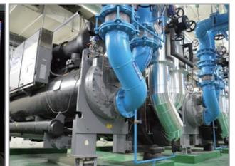
汰換高效率冰水主機抑低空調用電
