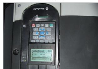
冰水泵及冷卻水泵採用變頻器控制
