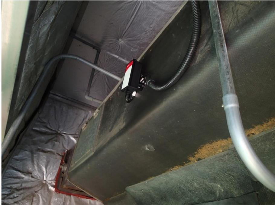
圖 4-12 空調箱回風端增設 CO<sub>2</sub> 計【15】
