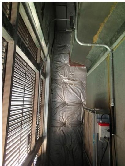
圖 4-13 空調箱外氣溫濕度計、外氣風門、回風 CO<sub>2</sub> 偵測計安裝位置【15】
