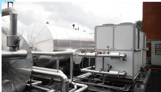
熱泵熱水系統(台北)
